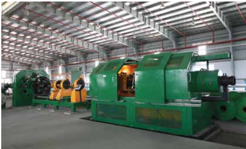
Hệ thống drum twister Drum twister system
